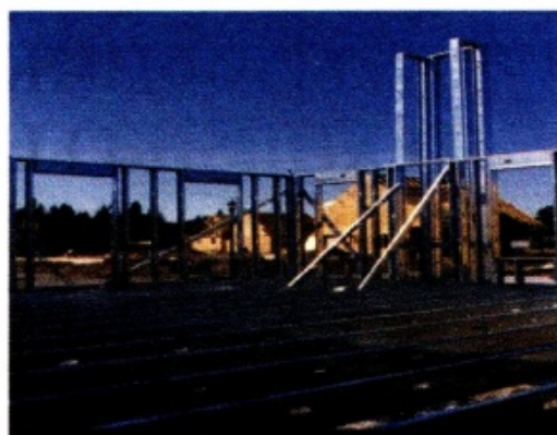
• Сл. 1.31. Монтажна градња •
