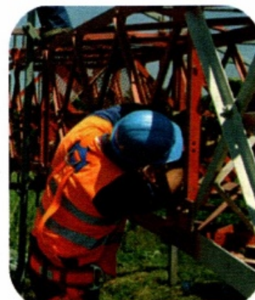
• Сл. 5.10. Заштита на градилишту •
