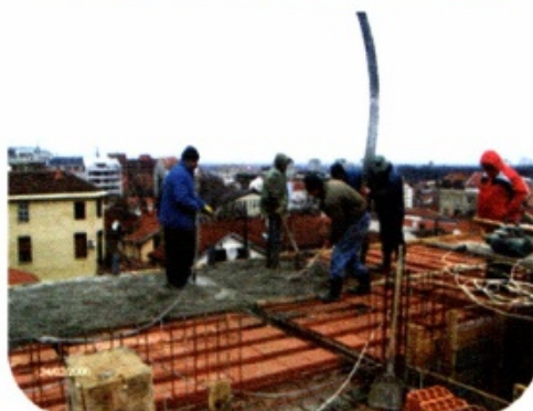
• Сл. 3.3. Бетонирање •
