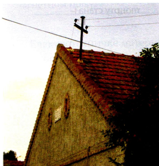
— Сл. 1.12. Надземни монофазни електрични прикључак на мрежу —
